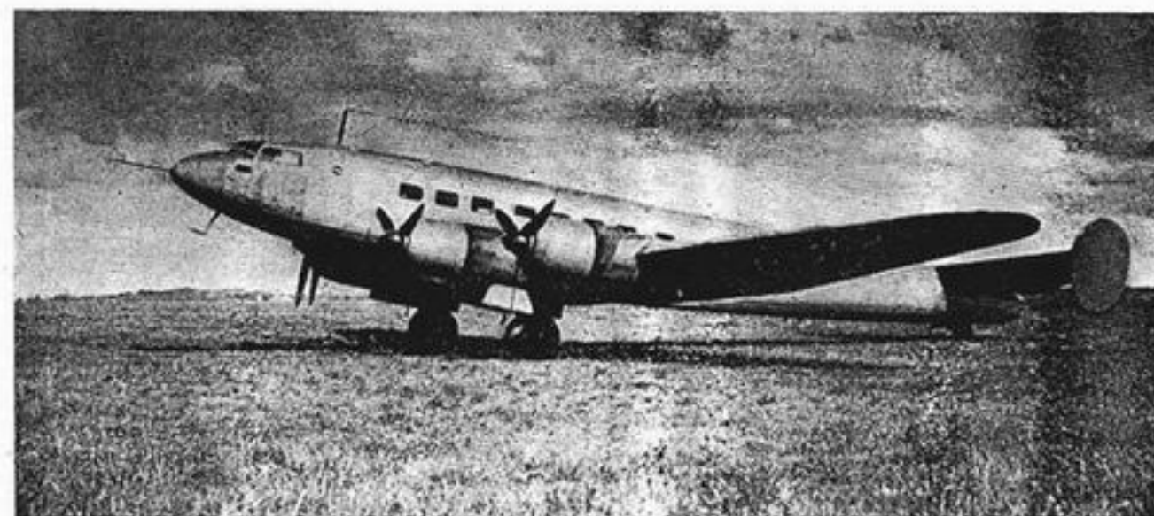
6. — QUADRIMOTEUR DE TRANSPORT BLOCH 161 "LANGUEDOC" 4 moteurs Gnome-Rhône 14 N 44-45
