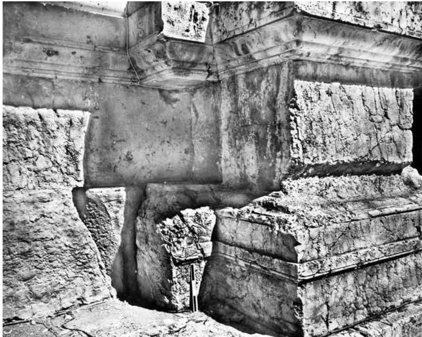
Figure 10. Joint oblique et assemblage en onglet d'un socle de colonne à l'intérieur du temple de Bacchus à Baalbek au Liban (© J.-Cl. B., CNRS-Ifpo, Mission Ifapo 1998).
